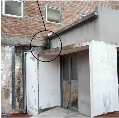
FILTRACIONES EN LA BAJADA SOBRE EL ALERO
