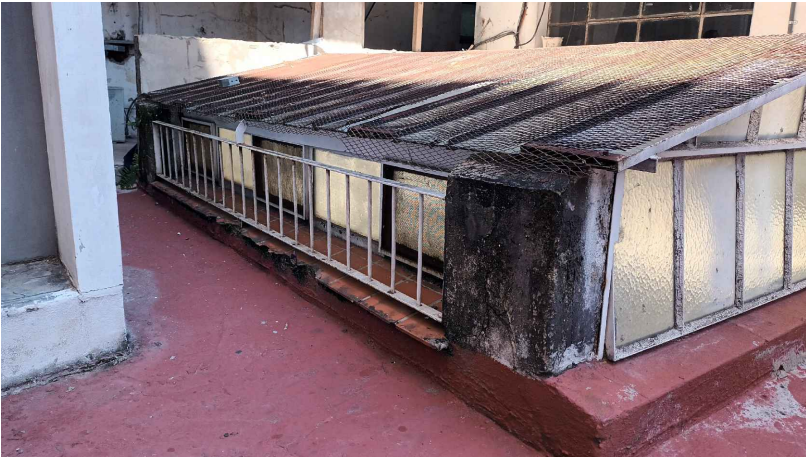
LUCERNARIO, FILTRACION, HUMEDAD EN LA LOSA Y EN EL MOJINETE
